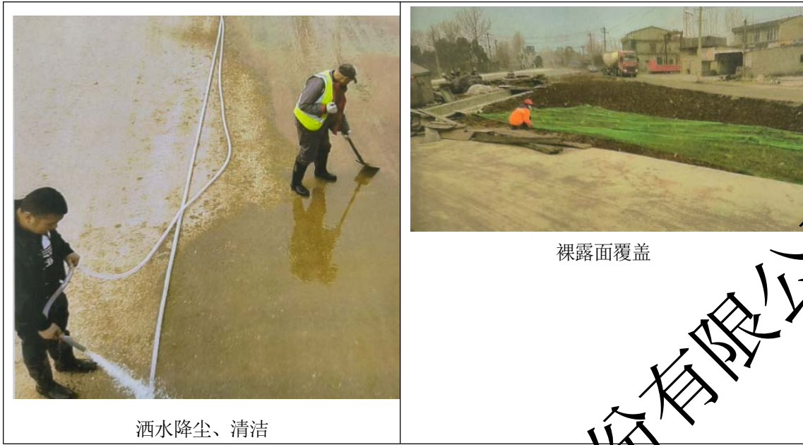
图 5.5-1 施工期现场抑尘照片
